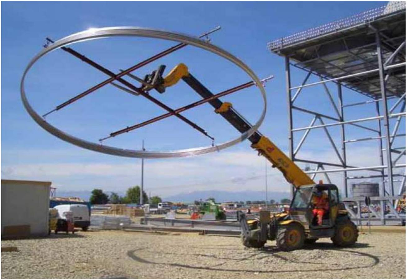
Fabricación directamente en sitio de algunas Juntas de Expansión DN 7200 en Italia.
