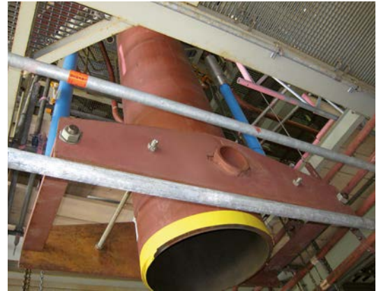
Tipo 34 con amortiguadores hidráulicos y dispositivos de fijación de posición
