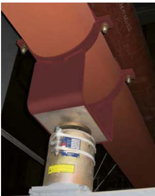
Placa deslizante de acero inoxidable bajo patín tipo 49, placa deslizante para altas temperaturas y soporte de carga variable tipo 29
