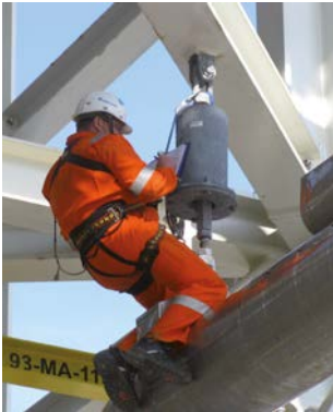
Comprobación de un soporte de tubería
