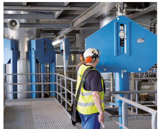
Inspección de la instalación de un soporte colgante de carga constante
