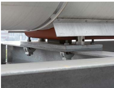
Patín con abrazadera tipo 49 sobre placa deslizante con conexión por abrazadera a la estructura de acero
