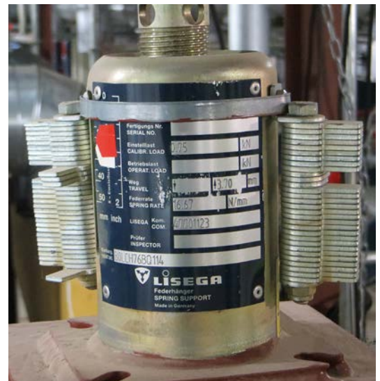
Tipo 29 con dispositivos de bloqueo acoplados
