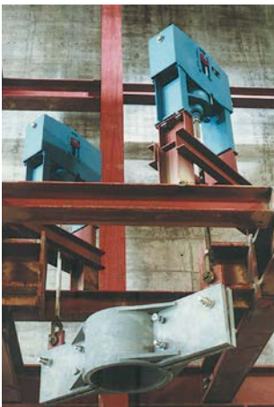
Soporte para sección de tubería vertical con diseño especial tipo 45
